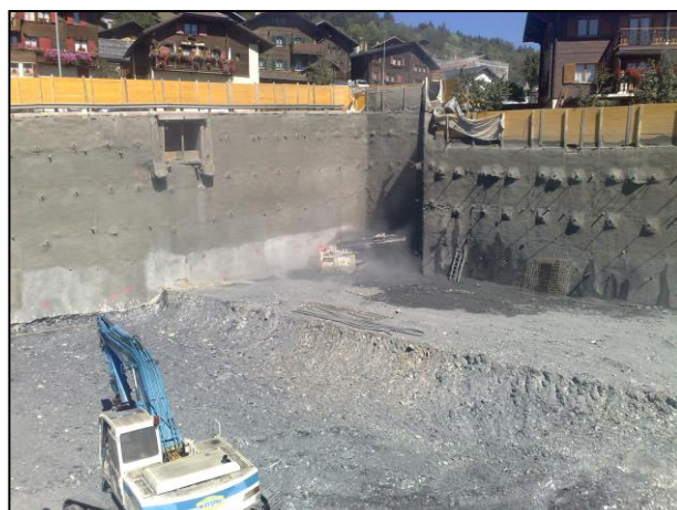
Abaissement culée Est pont Haut de Crans
