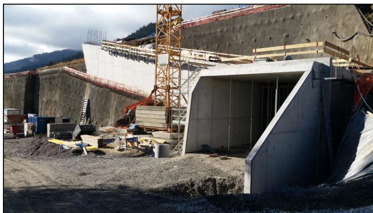
Tranchée couverte – ALRV - Aminona
