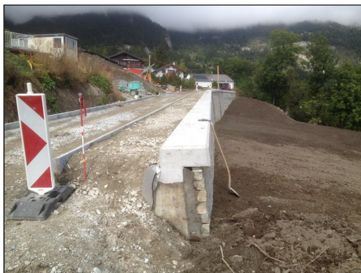
Route de Voirambeys avec mur de soutènement - Mollens
